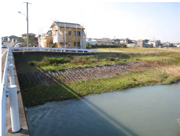
生態系に配慮した改修後の蛇籠による工法
