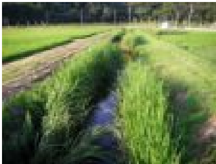
図-1 水路(排水路)
