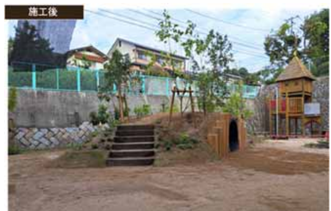
図1 すいこう認定こども園園庭改修工事ご提案 図2、3 着工前、施工後
