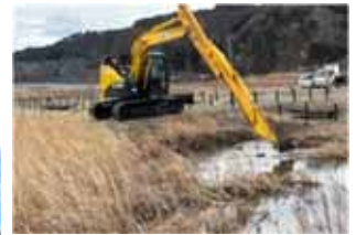
ガマ・ヨシ繁茂対策・根茎拔去重機作業 4/3
