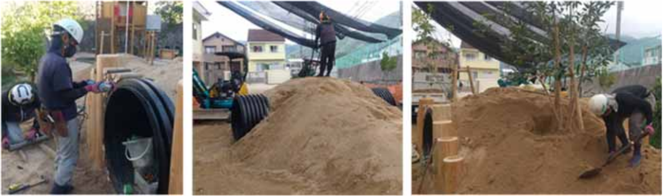
図4、5、6 施工状況 / プレスト管削り加工、整地・転圧、植栽
