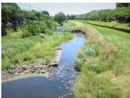
図7. 神明橋下流、工事前 2016年6月2日(撮影)
