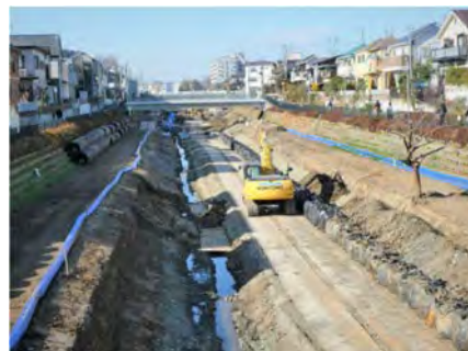
図3. 小足立橋上流、工事中 2021年1月7日(撮影)
