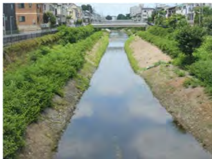
図2. 小足立橋上流、工事後 2021年6月18日(撮影)
