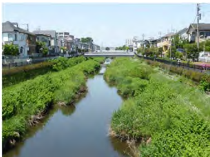
図1. 小足立橋上流、工事前 2014年5月4日(撮影)
