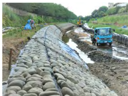
図6. 谷戸橋下流、工事中 2020年8月25日(撮影)
