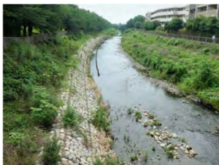
図5. 谷戸橋下流、工事後 2021年7月11日(撮影)
