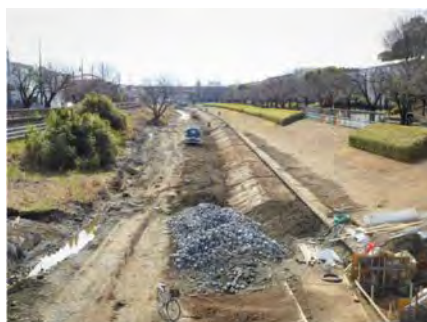
図9. 神明橋下流、工事中 2019年2月22日(撮影)
