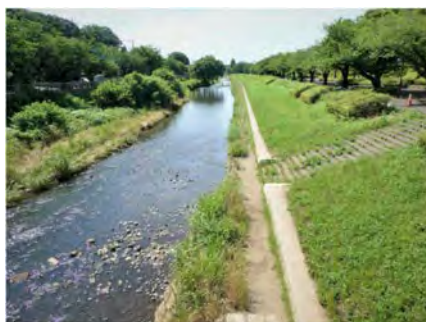
図8. 神明橋下流、工事後 2020年6月17日(撮影)
