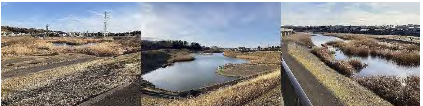
俣野遊水地ビオトープ (令和5年2月撮影)
