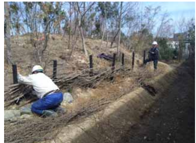
土留め工法、粗朶柵を施工
