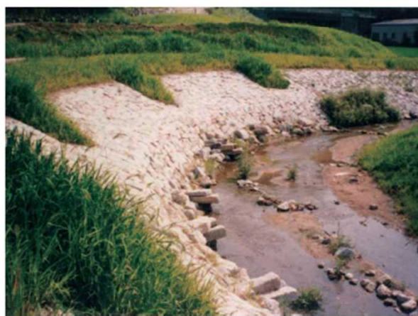
護岸のVカット
