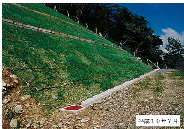
写真1 緑化区の例。1998年。客土、播種、植栽を組み合わせで緑化。
