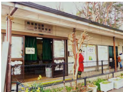
図1. 渋谷より井の頭線に乗り、二駅先の駒場東大前で下車。西口を出て線路に沿って坂を上ると児童館があり、その隣の平屋の建物が「駒場野公園自然観察舎」で、公園のボランティア活動の拠点を担っています。
