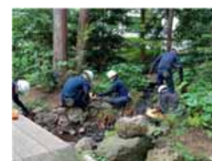
企業ビオトープ水路補修の様子
