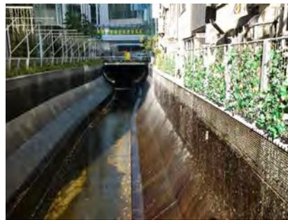
図2. 渋谷川1-稲荷橋上流: ビル街の地下から突如姿を現した流れが、渋谷川の今の姿である。三面コンクリートの溝を流れる澄んだ水は、下水を処理した再生水である。
