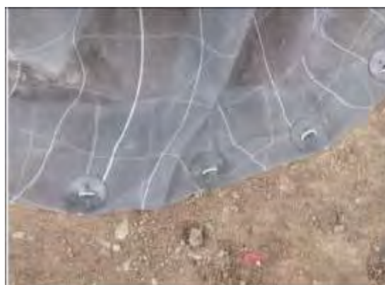
写真12 底部U型ピン固定 ネットを内部へ折り返す
