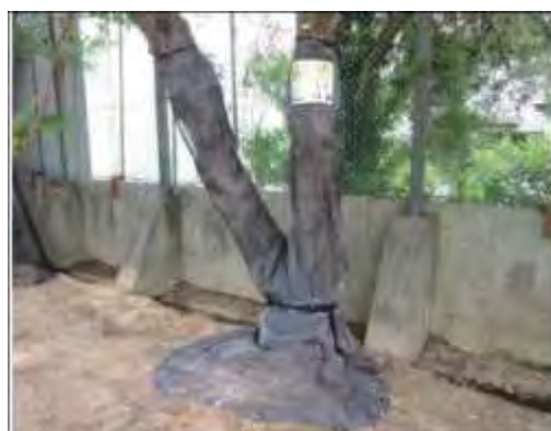
写真10 ネット張り後のイメージ 縦のテープは後に施工
