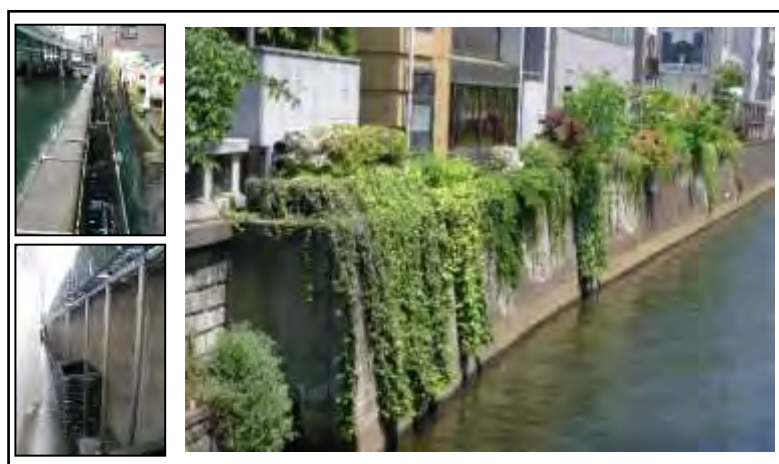
図-2 支持構造体と7年目の護岸景観(水面まで約4m)
