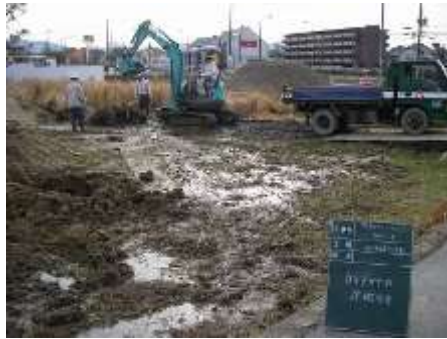
剥ぎ取り群落積み込み (平成 20 年 2 月 2 日撮影)
