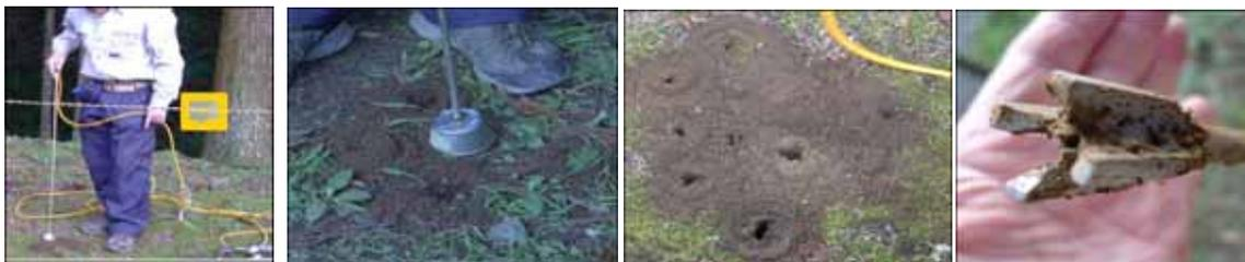
写真25 作業風景 写真26 土壌の飛散防止 写真27 穿孔後 写真28 ノズル先端
