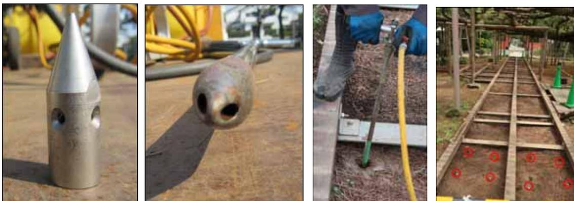
写真21 先端4孔ノズル 写真22 先端2孔ノズル 写真23 印まで穿孔 写真24 完了
